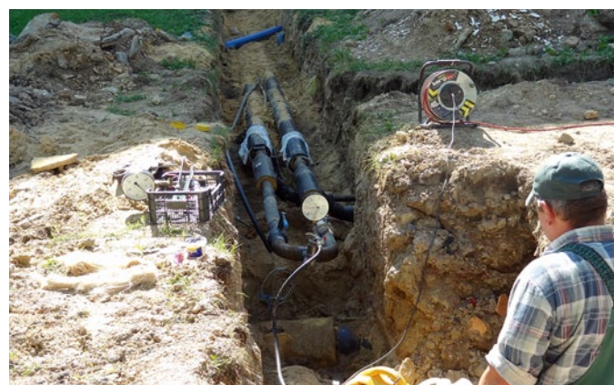
Z2A.15 – „Przebudowa osiedlowej zewnętrznej instalacji odbiorczej dla potrzeb indywidualnych węzłów ciepłych GWC (SW-2) ul. Sadowa w Radzionkowie” – próba ciśnieniowa.
