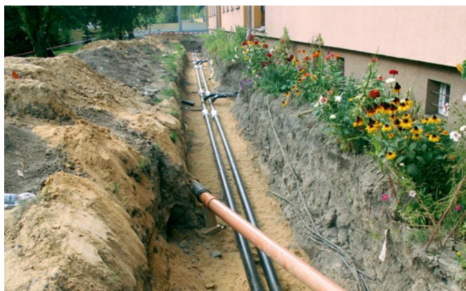
Zadanie Z1A.24 „Wymiana osiedlowej zewnętrznej instalacji odbiorczej zasilanej z GWC ul. Bema wraz z przebudową grupowego węzła ciepłego w Bytomiu”.
