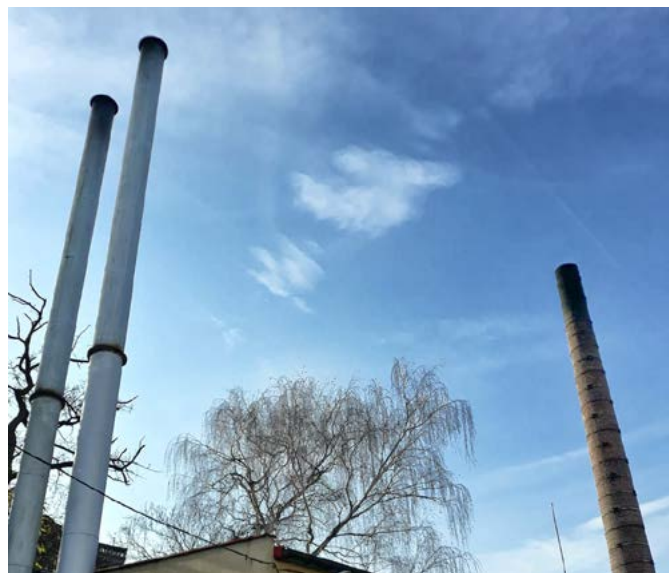
Szpital nr 2 w Bytomiu – nieczynna kotłownia
