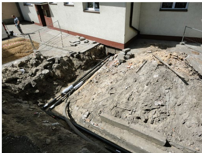
Budowa przyłącza sieci ciepłowniczej do budynku przy ul. Matejki 29.
