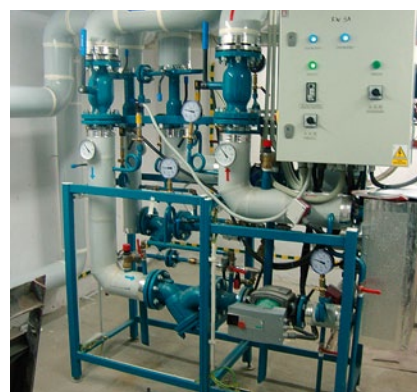
2012 r. Modernizacja węzła cieplnego ul. Narutowicza 22 w Bytomiu.
