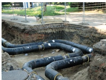
2011 r. Sieć ciepłownicza po wymianie ul. Tarnogórska w Bytomiu.
