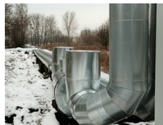
2011 r. Sieć napowietrzna po wymianie izolacji termicznej w Bytomiu.
