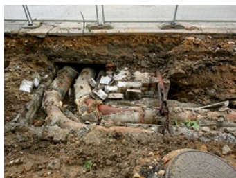
2011 r. Sieć ciepłownicza przed wymianą ul. Tarnogórska w Bytomiu.
