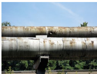
2011 r. Sieć napowietrzna przed wymianą izolacji termicznej w Bytomiu.
