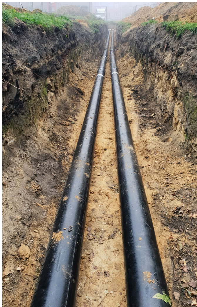
Nowa sieć ciepłownicza budowana jest m.in. w Łagiewnikach.
