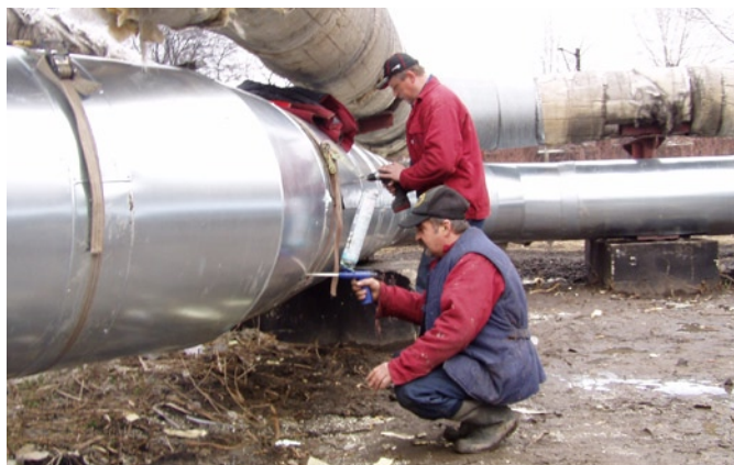
Trwają naprawy izolacji termicznej sieci ciepłowniczej.
