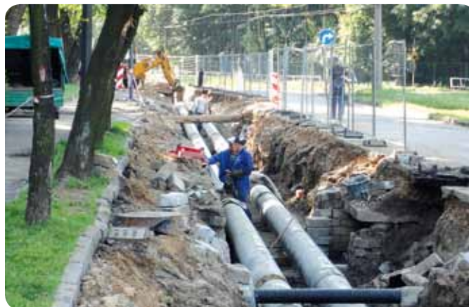
Wymiana sieci ciepłowniczej pod ul. Tarnogóską w Bytomiu
