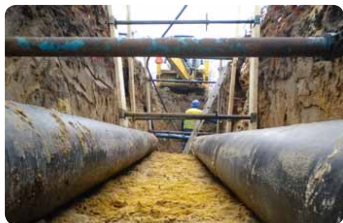
Przebudowa sieci ciepłowniczej przy ul. Knośały w Radzionkowie
