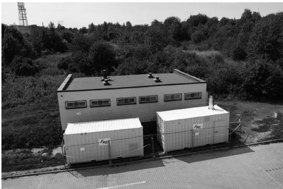
Kotłownia kontenerowa w Radzionkowie...
